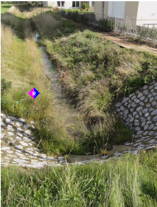
Offene Ableitung von Niederschlägen im Quartier
