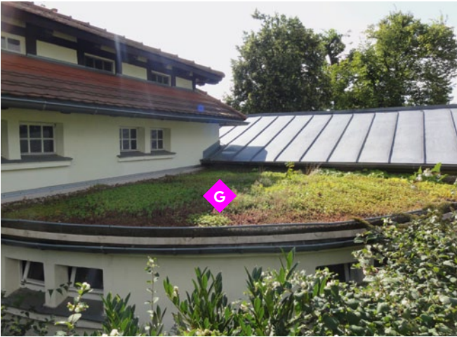
Dachbegrünung hält Niederschlagswasser zurück und kühlt das Gebäude.
