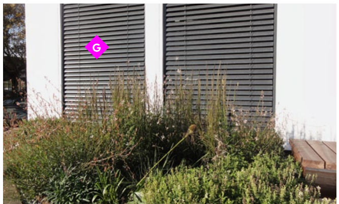
Hitzeschutz am Gebäude durch außenliegende Verschattung, helle Fassade und Grün.
